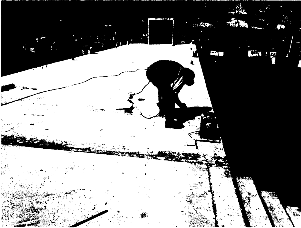
CORTE Y PICADO DE CONCRETO
