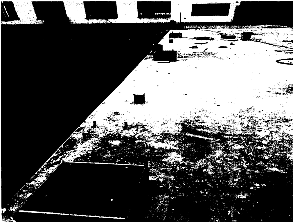
Encofrado de dados de concreto 0.40 x 0.40 m
