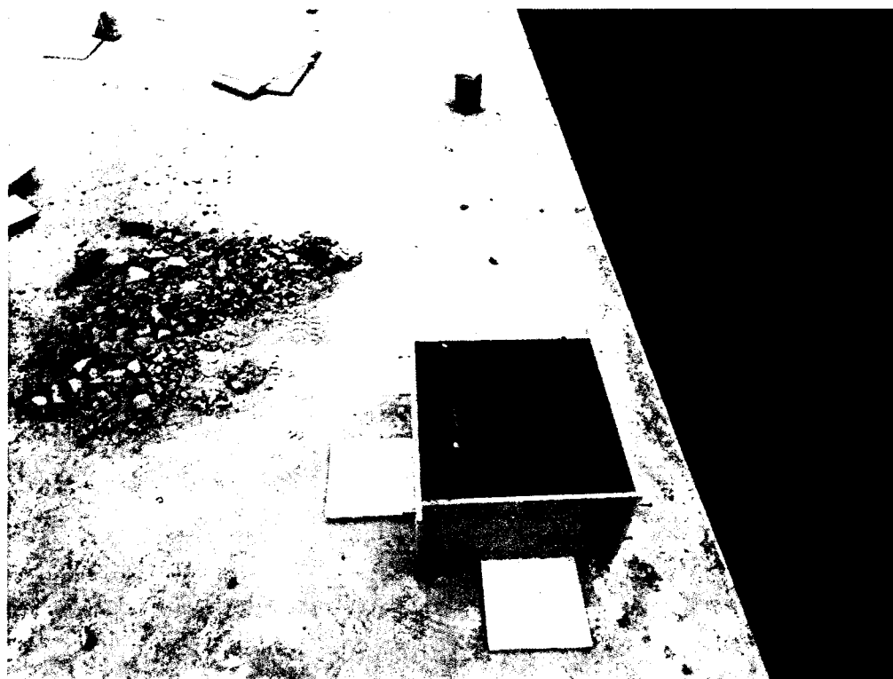
Encofrado de dados de concreto 0.40 x 0.40 m
